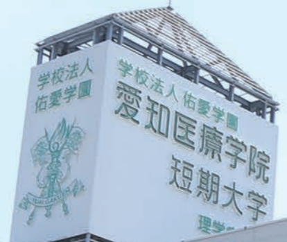
短期大学校舎外観
